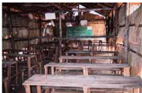
最近完成した教室内部
